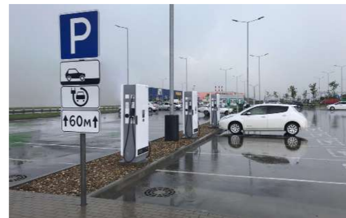
Примеры организации площадки с оборудованием стоянки для зарядки электромобилей
