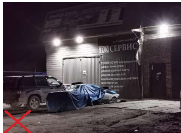
Недопустимо устанавливать светильники (прожекторы) со слепящим эффектом.
