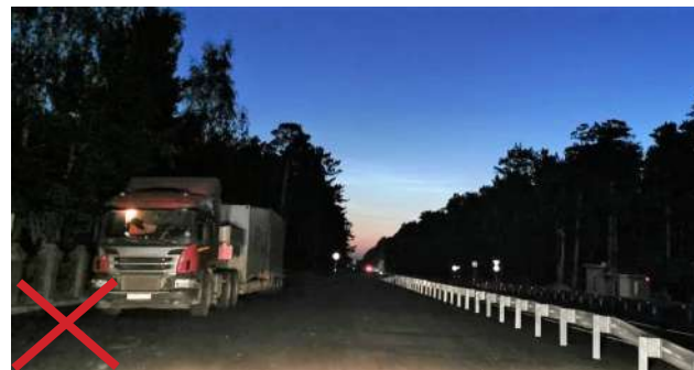
Недопустимо не предусматривать дежурное освещение на объектах ОДС в тёмное время суток.
